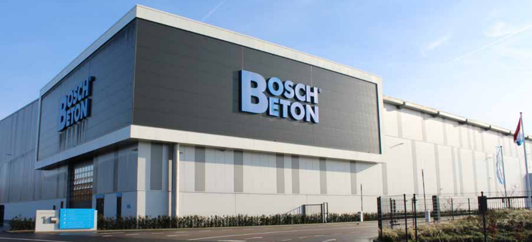
Hart van de nieuwe betonfabriek vormt de betoncentrale.
